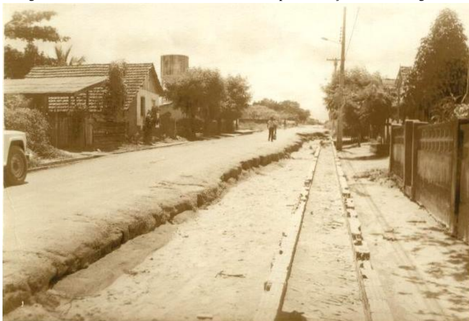
Fotografia 36: Travessa Carlos Maria Teixeira sem pavimentação e rede de esgoto.
