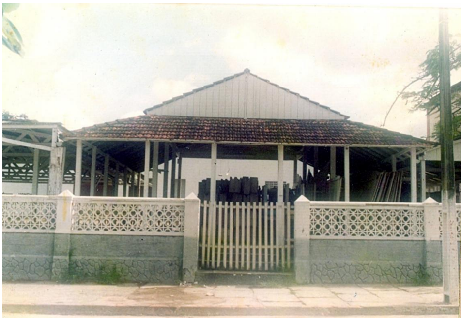
Fotografia 48: Clíper da igreja de Santo Antônio.
